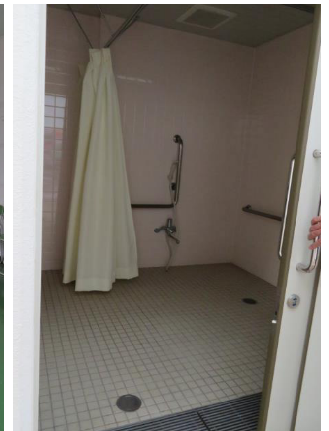
バリアフリー化されたシャワールームのある避難所
