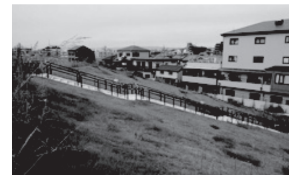
写真1 大和川右岸堤防から見た瓜破西地区
