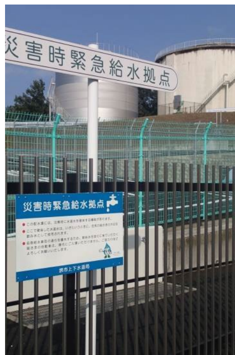
写真5 御池台配水池
