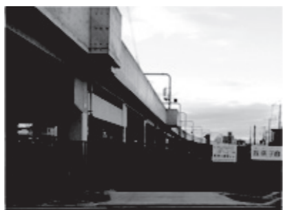
写真7 鉄道廃線敷地と高架橋周辺の状況
