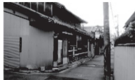
写真6 家屋密集地の状況 (コンクリートブロックや道路沿いの老朽化した木造家屋)
