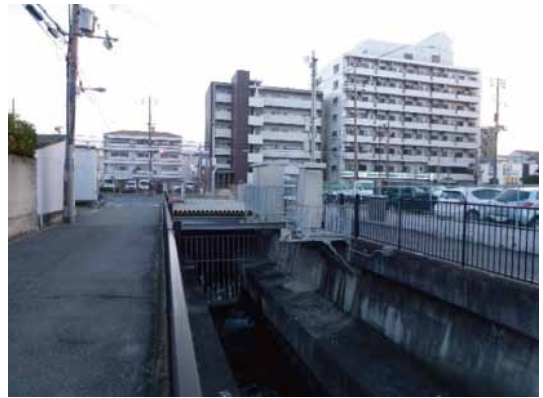
写真3 現在の駒川最上流部となにわ大放水路への会所(雨水流入口)
