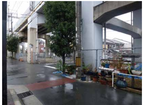
写真5 近鉄南大阪線の高架橋の様子
